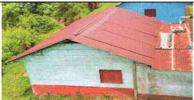
Se observa el deterioro de las laminas de la cocina.
