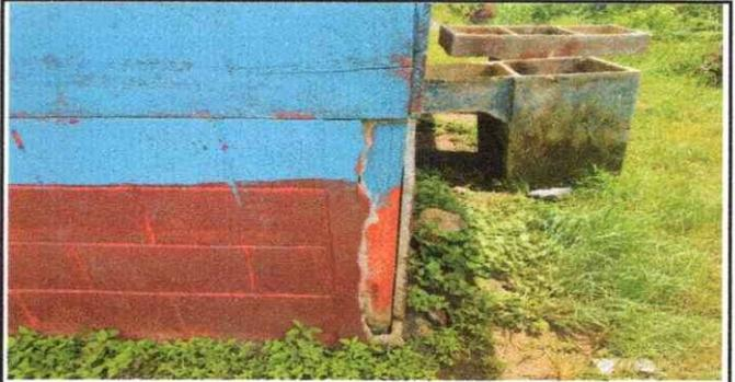
Se observa el daño por el deterioro de las esquinas de la cocina.
